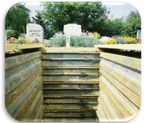
Bild: praxistauglicher Verbau durch verstellbare Verbauelemente aus Stahl oder Aluminium
