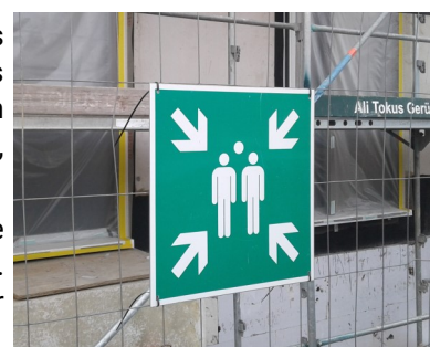
Kennzeichnung einer Sammelstelle auf einer Baustelle Bildquelle: SVLFG
