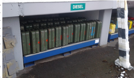
Übersichtliches Kraftstofflager mit Auffangwanne Bildquelle: SVLFG
