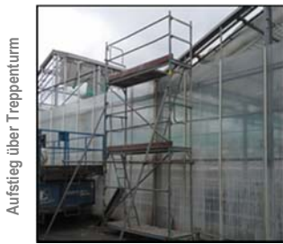
Sicherung mit Fangnetzen und Verwendung eines Laufsteiges
