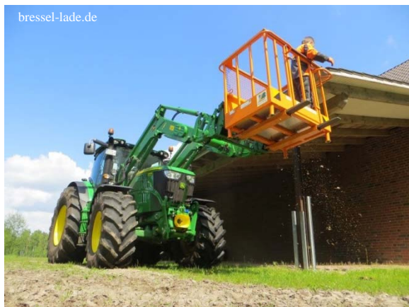
Sichere Reinigung der Dachrinne von einer Arbeitsplattform aus
